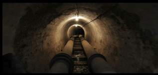
地下管廊测绘
